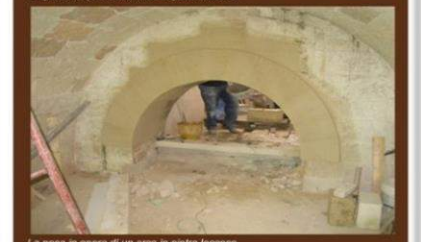
La posa in opera di un arco in pietra leccese
