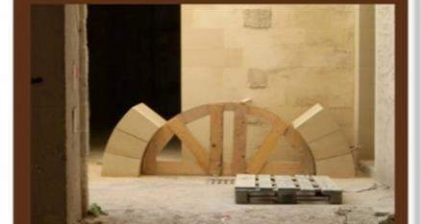
Posa a "secco" dei conci sagomati per la formazione di un arco
