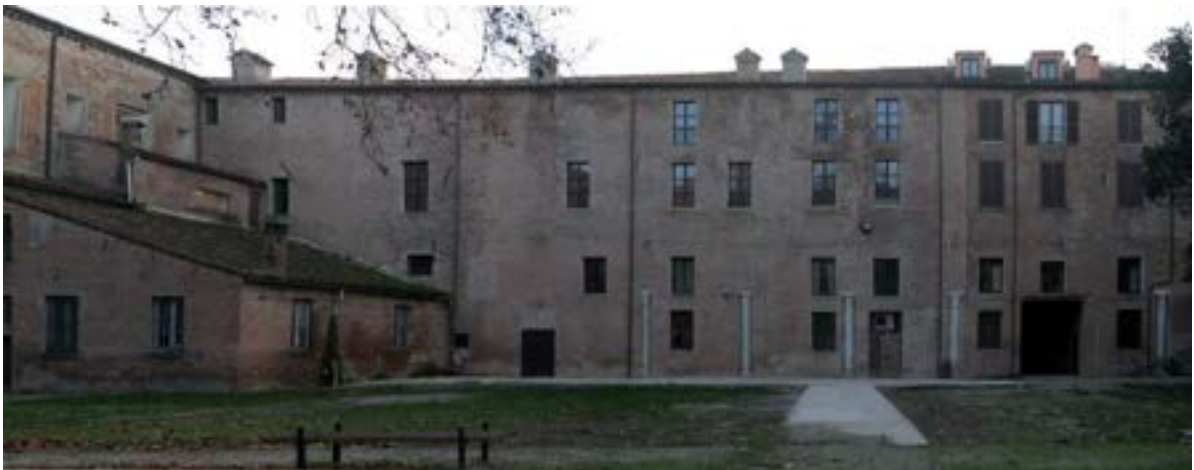
Prospetto sul Giardino delle Duchesse del corpo di fabbrica "ex Bazzi" dopo i lavori di restauro.
