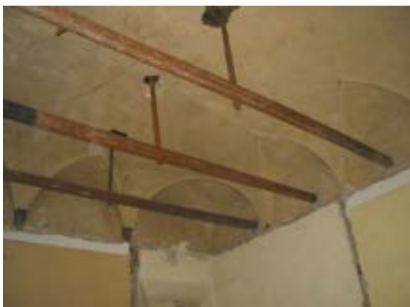
La scoperta del soffitto ligneo a cassettoni con rosette dorate dopo la rimozione di un primo controsoffitto piano in canniccio che era posto a livello dell'imposta del superiore controsoffitto voltato
