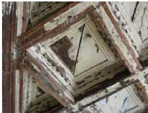
particolare soffitto ligneo decorato
