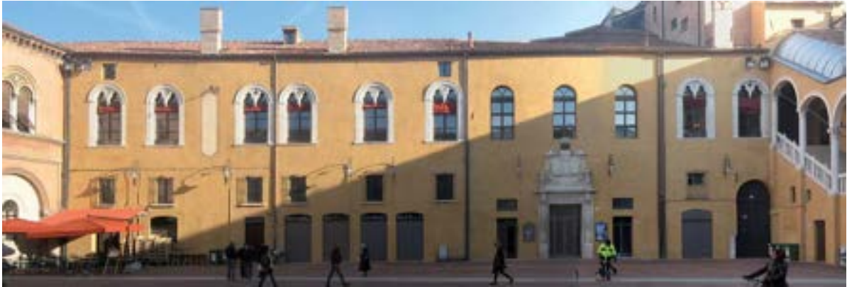
Prospetto su Piazza Municipale del corpo di fabbrica " ex Bazzi" come ci appare oggi, dopo i lavori di restauro eseguiti ltra il 2008 e il 2010.
