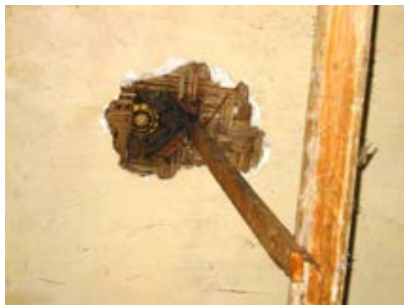
La scoperta del soffitto ligneo a cassettoni con rosette dorate dopo la rimozione di un primo controsoffitto piano in canniccio che era posto a livello dell'imposta del superiore controsoffitto voltato
